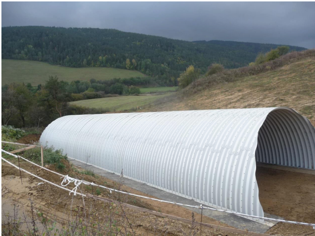
Obr. 2 Mostný objekt SO 205-00 pred zásypom
