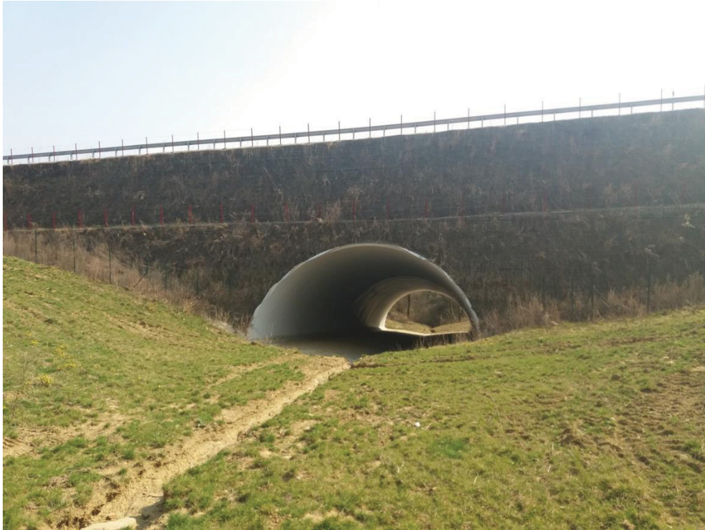
Obr. 3 Mostný objekt SO 205-00 po zásype
